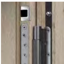
4 bezpečnostné trne proti vysadeniu protipožiariarne tesnenie (Typ II)
