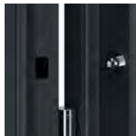
bezpečnostný trň proti vylomeniu
