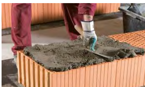
Murovanie klasických tehál na klasickú vápenocementovú maltu
