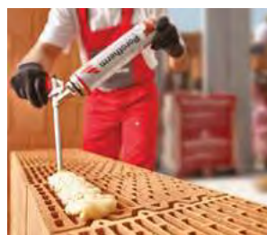
Nanášanie peny Dryfix pomocou aplikačnej pištole
