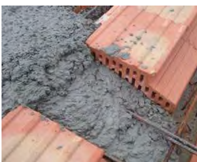
Detail stropu počas betónáže
